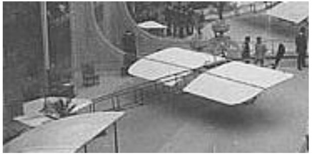
Deux modèles ont été construits, qui tout deux ont subi de nombreuses modifications qu'il est difficile de préciser (train, ailerons, position des radiateurs), le système propulsif restant inchangé. Le plan microscopique paru dans Aviation Magazine comporte de nombreuses erreurs. En particulier, la partie mobile des
